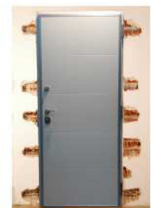
9. Instalación sin obra El uso de resina de dos componentes permite una instalación sin obra de alta resistencia. Si la debilidad del muro no permite el uso de la resina la puerta podría ser fijada mediante albañilería.
